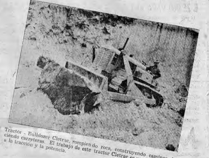
Tractor - Bulldozer Cletrac, rompiendo roca, construyendo caminos, haciendo carreteras. El trabajo de este tractor Cletrac es un verdadero reto a la tracción y la potencia.
